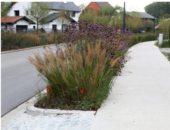
Infiltratiestroken kunnen een oplossing bieden voor waterinfiltratie langs wegen met minder plaats (Bron: blauwgroenvlaanderen.be )
