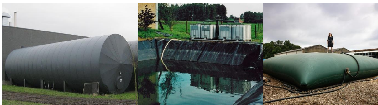
Buffertanks, een foliebekken en een zak, voor de opslag van regenwater (Bron: Sumaqua & ZES, 2021).
