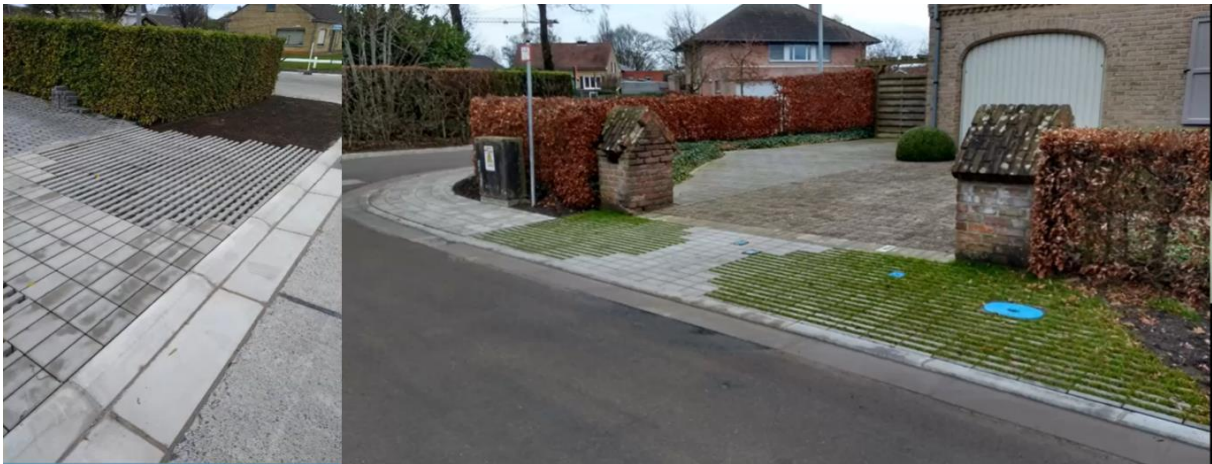
Voorbeelden van deel van het wegprofiel in waterpasserende verharding, met behoud van gebruiksvriendelijke toegankelijkheid. (Bron foto's: Aquafin).
