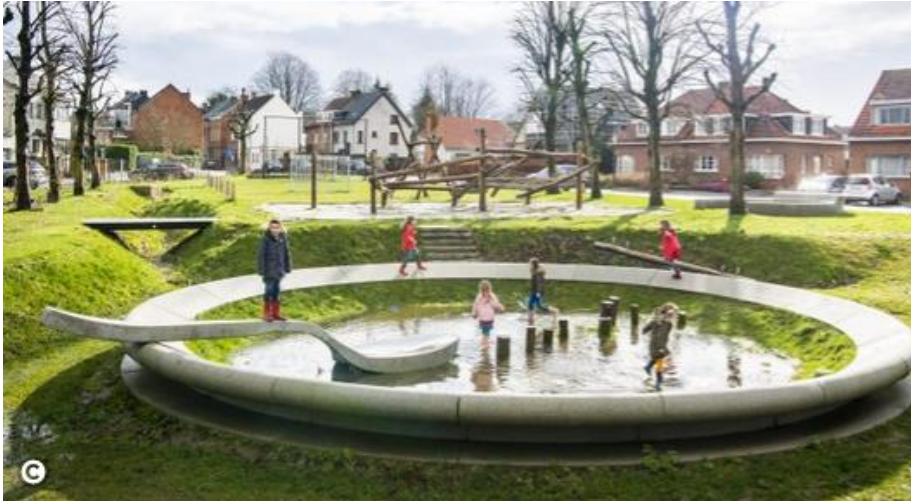
Laagteberging en infiltratie in het openbaar domein. Edegemsesteenweg Kontich (Bron: blauwgroenvlaanderen.be )
