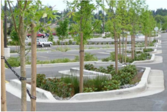
Voorbeelden van aanleg van verlaagde plantvakken waarbij water van de omliggende verharding afstroomt naar het plantvak om daar te infiltreren (Bron: www.urbangreenbluegrids.com/measures/urban-infiltration-strips/ © z.j., Gemeente Hamburg).
